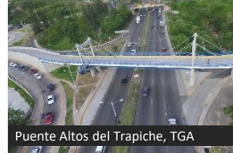
Puente Altos del Trapiche, TGA
