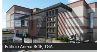
Edificio Anexo BCIE, TGA
